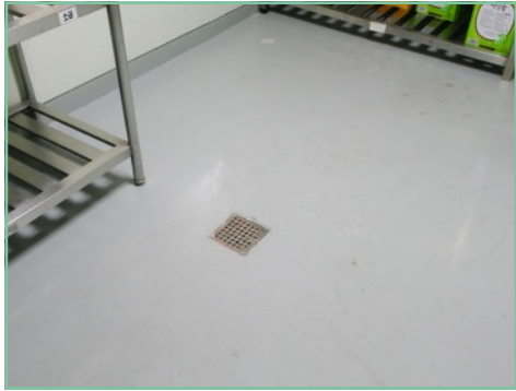
식품창고 바닥의 배수시설
